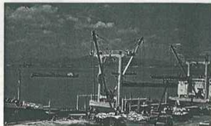
建設中的天然深水良港——道州灣秀鋼港
